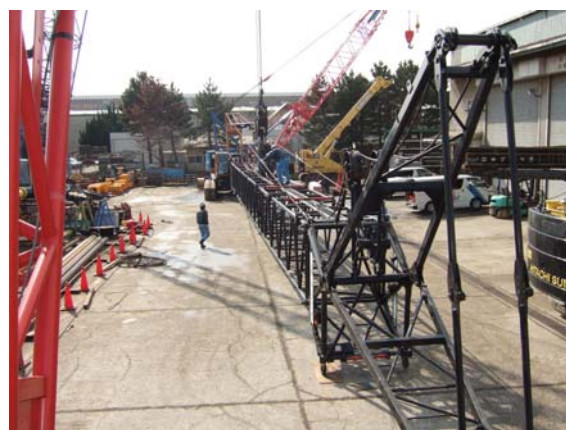
ブームを点検中
